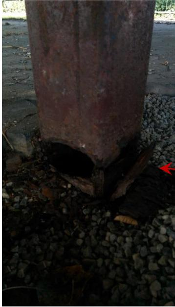
*Bild: durchgerostete Stütze am freigelegten Fußpunkt*
