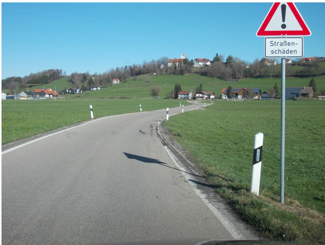
Bild 4: Beschilderung von Bauwerk kommend Richtung B 12
