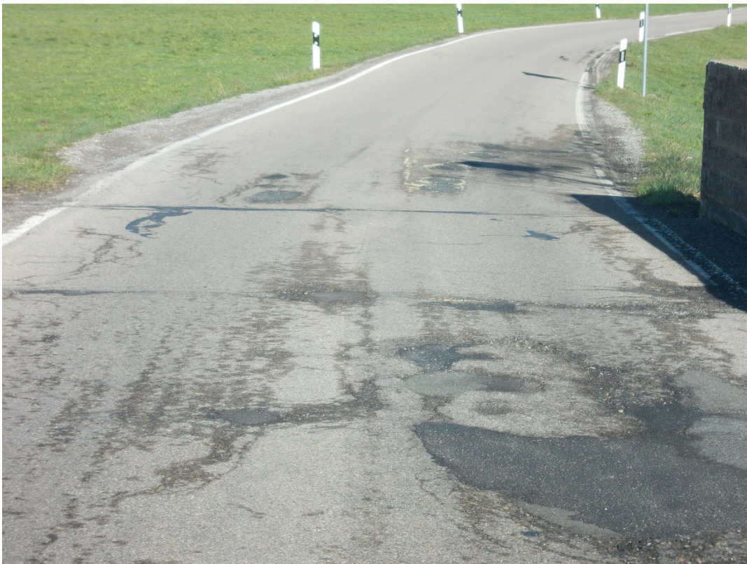
Bild 2: Belag auf Bauwerk, Blick Richtung B 12
