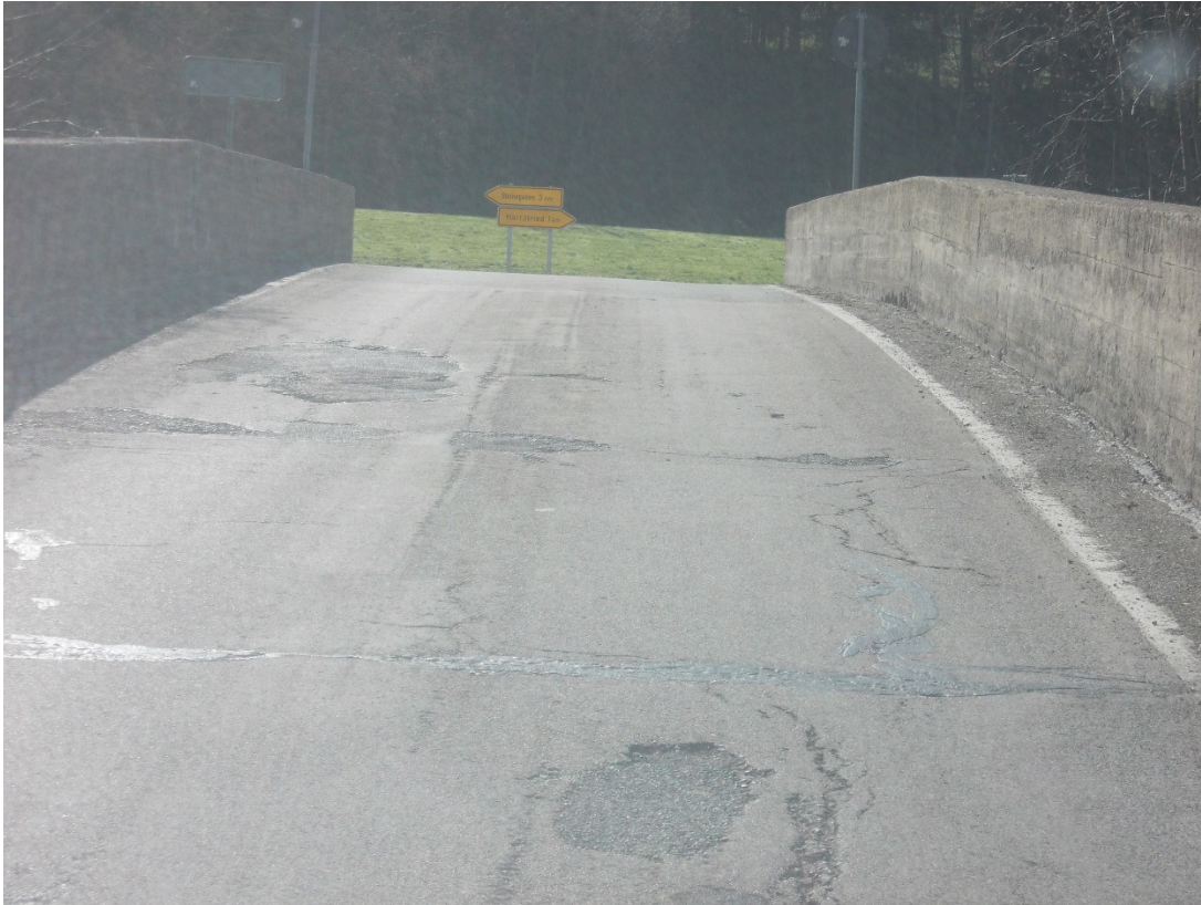
Bild 3: Belag auf Bauwerk, Blick Richtung Bayern
