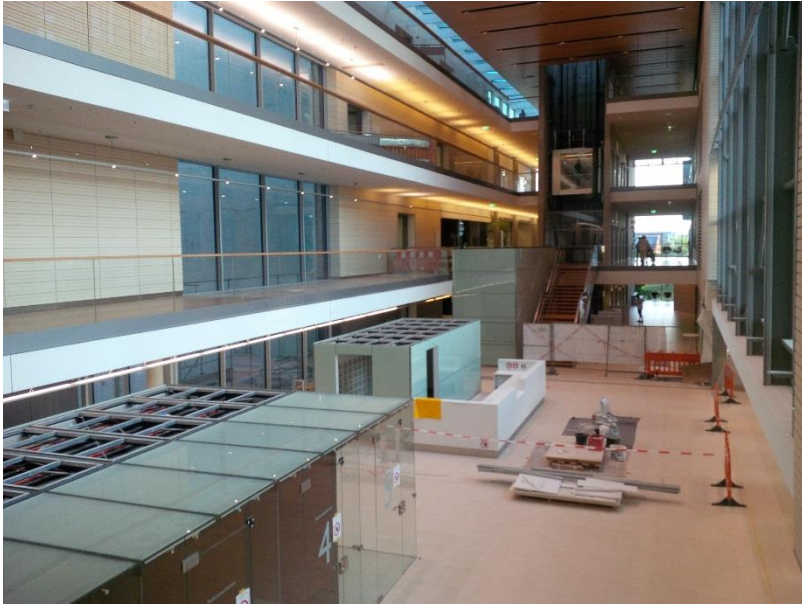
Magistrale nach Abbau der Staubwand
