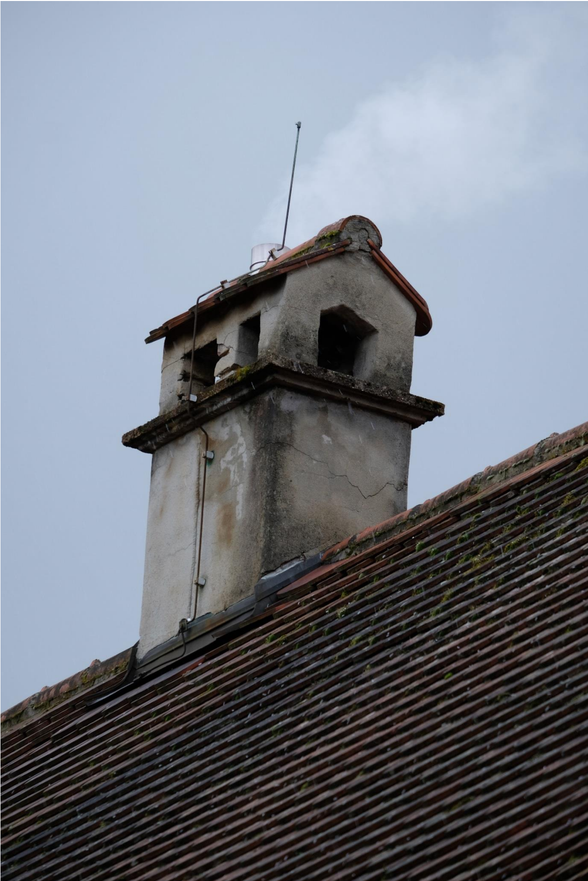
Detail Kaminkopf Amtshaus
