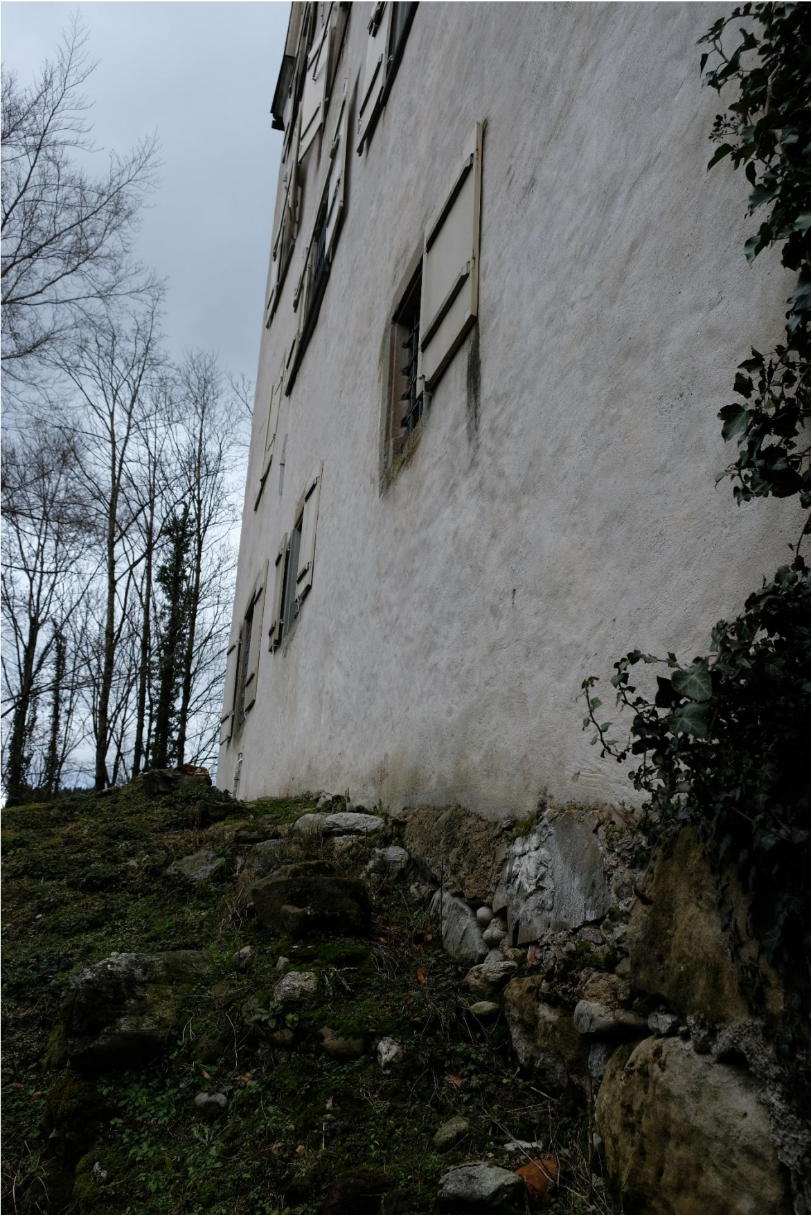
Ansicht West (unterer Teil)
