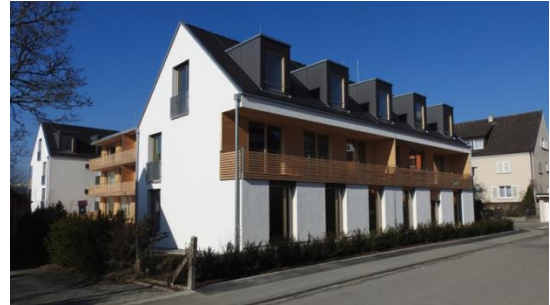
Mehrgeschosser in Hybridbauweise in Weingarten Planung: Architekturlokal Ravensburg
