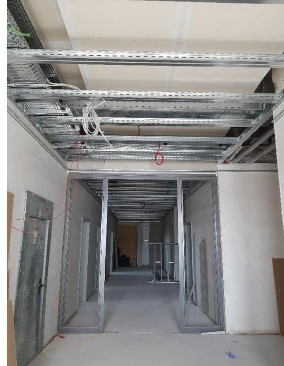
In der Ebene +3 im Behandlungsbau werden aktuell die abgehängten Decken im Flur montiert.
