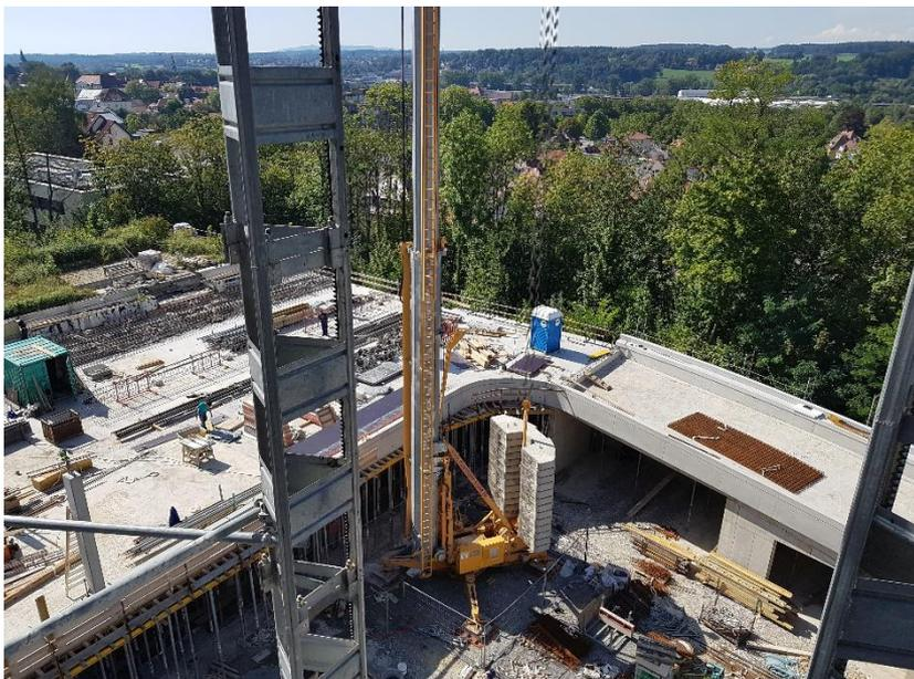
Das Rampenbauwerk und die Decke über der Ebene -1 der Liegendkrankenvorfahrt sind betonierte. Aktuell werden die aufgehenden Bauteile erstellt.
