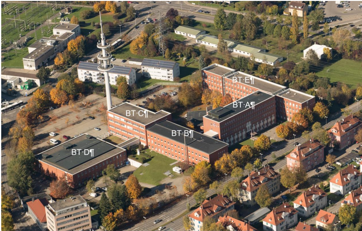
Bild: Übersicht Kreishaus II, Ravensburg
