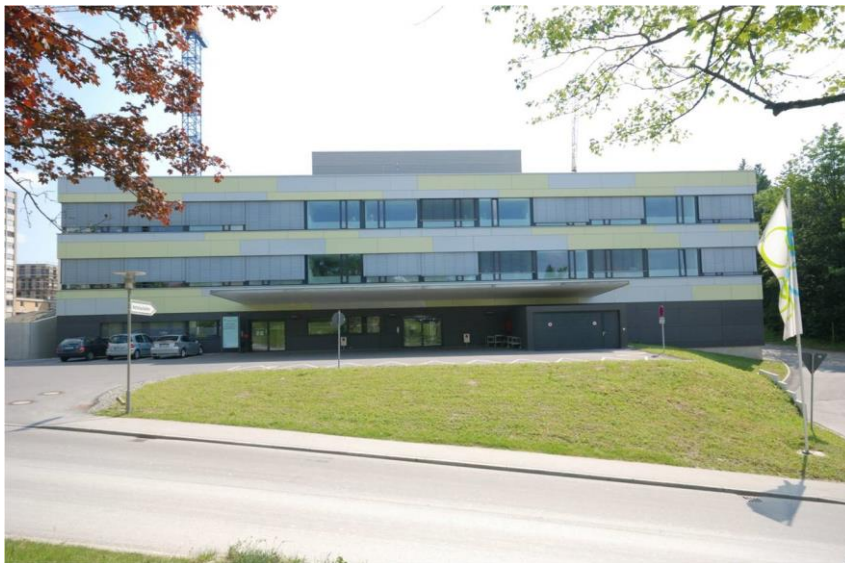
Bild: Ansicht Nord Bauteil F, Interimsnotfallgebäude
