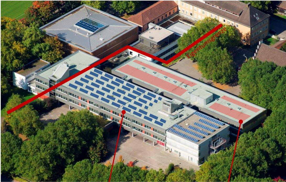
Geplanter Aufbau für Photovoltaik (80 kWp)
